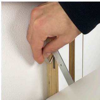
Mit Hilfe eines zweiten Magneten kann der eingesteckte Magnet entfernt werden / With the help of a second magnet the inserted magnet can be removed
